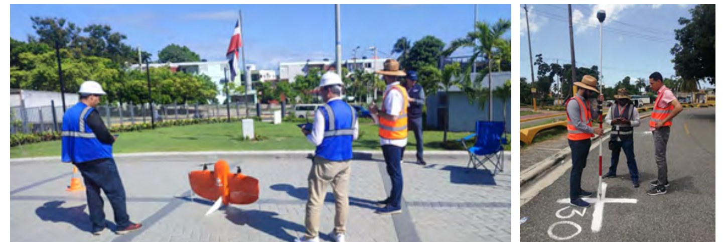
Fotografía 4. Proceso de levantamiento de información a partir de drones (izq.) y de comprobación de cotas (der.)
